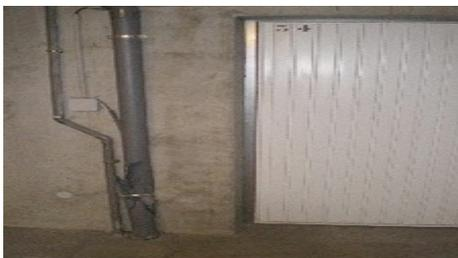
Un tuyau en PVC, à côté du garage n°34 niveau -2, a été endommagé, probablement par un véhicule effectuant une manœuvre.
